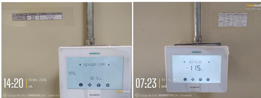
Foto 53-54. Fallas en pantallas de registro de temperatura
