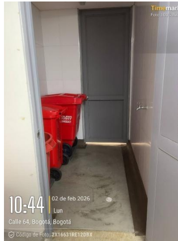
Foto 49. Almacenamiento de residuos peligrosos con características infecciosas (Biosanitario y Cortopunzantes).
